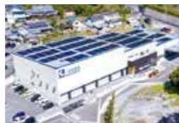
▲工場の屋根に 太陽光発電パネルを設置
